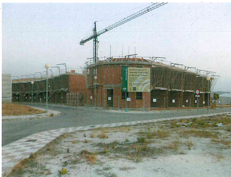
Nueva construcción de Viviendas de Protección Oficial.
