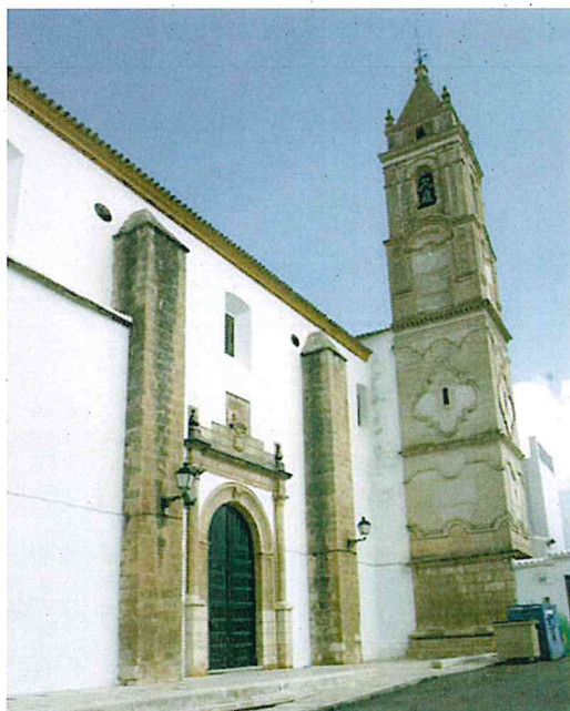
Torre e Iglesia San Sebastián.
