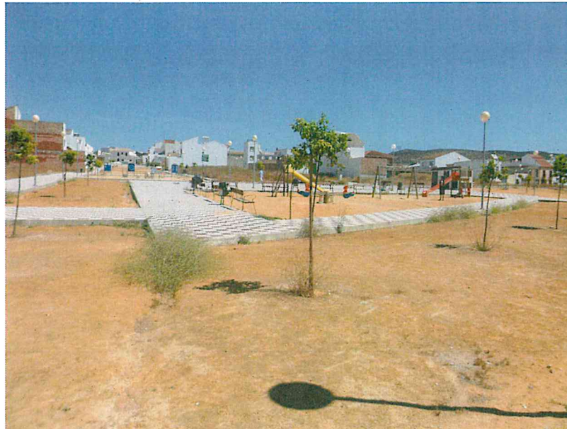
Parque público en mal estado.
