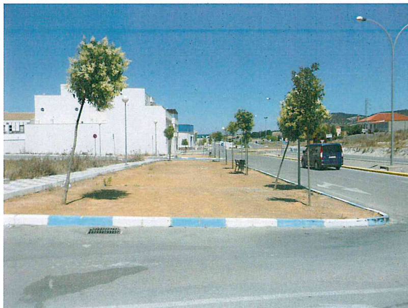
Zona verde en mal estado.
