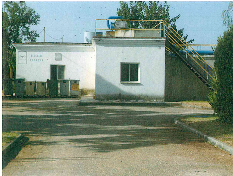
EDAR de Pedrera.
